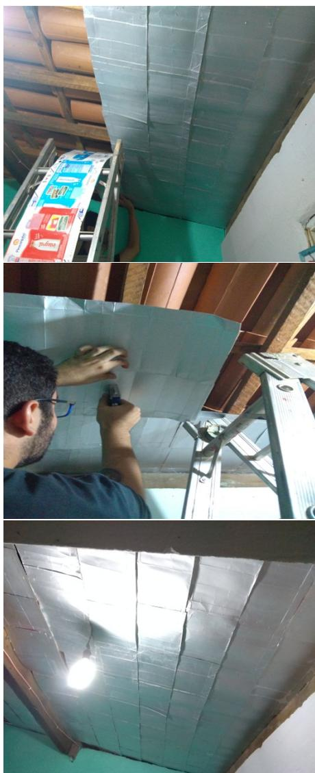
**Figura 8.** Caixas sendo fixadas na estrutura de madeira do telhado com o auxílio do grampeador de pressão (A-B) e caixas após fixação (C).
